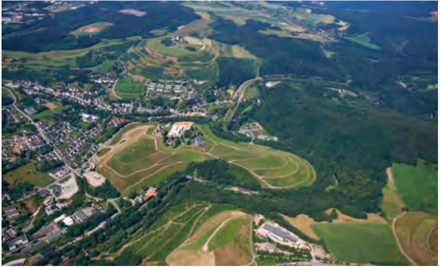
Gesamtansicht Haldenlandschaft Bad Schlema und Aue 2015
