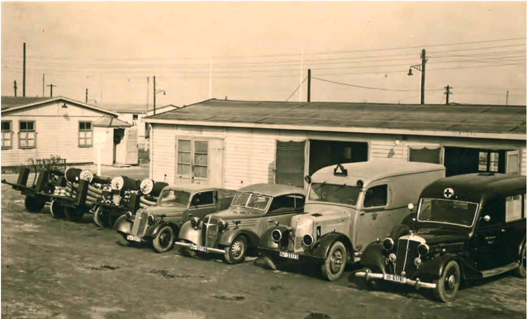
Abb. 54: Foto einer Funktionsbaracke im Wohnlagerkomplex Espenhain
