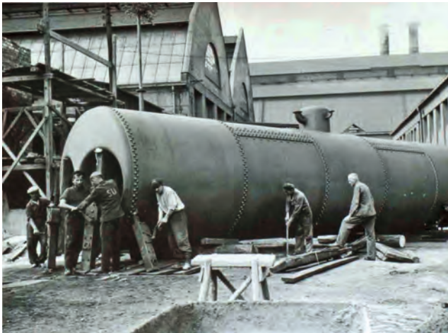
Abb. 33: Zwangsarbeiter beim Transport eines Heizkessels 577
