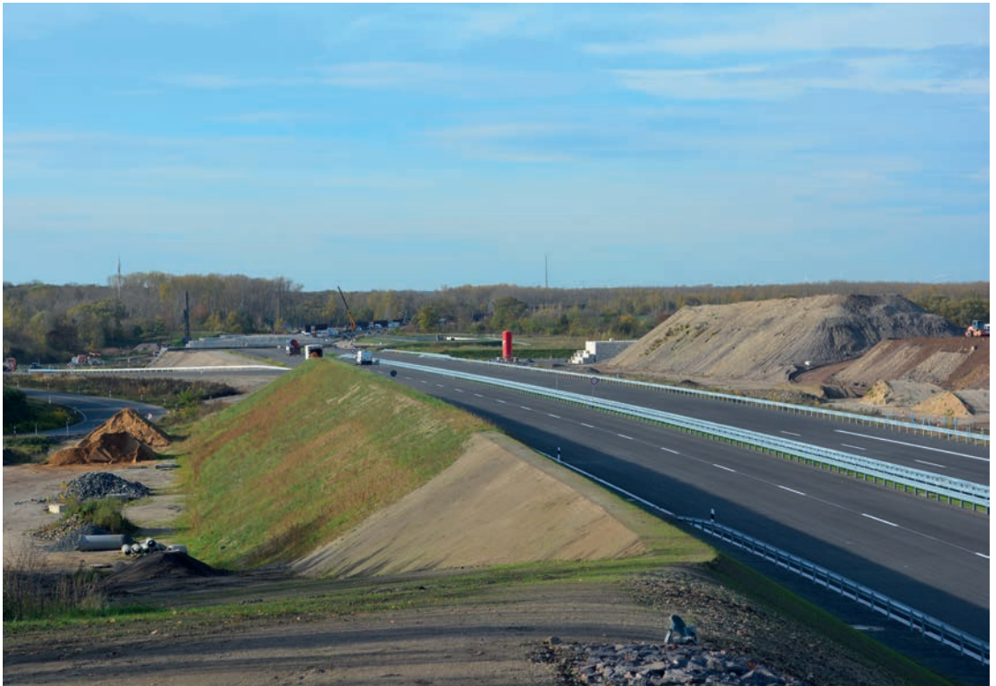
Fertigstellung des Teilstücks der A 72 Chemnitz-Leipzig bei Rötha, Kreis Leipzig
