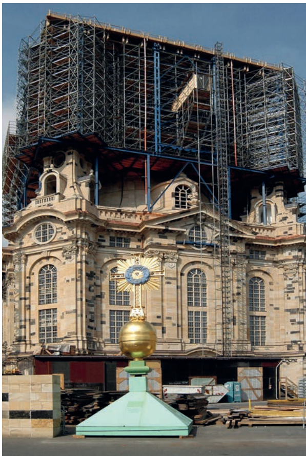
Dresdner Frauenkirche beim Wiederaufbau, 1995
