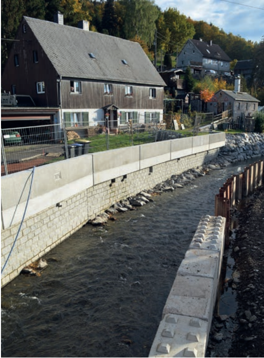
Hochwasserschutzanlage in Burkhardtsdorf/Erzgb.
